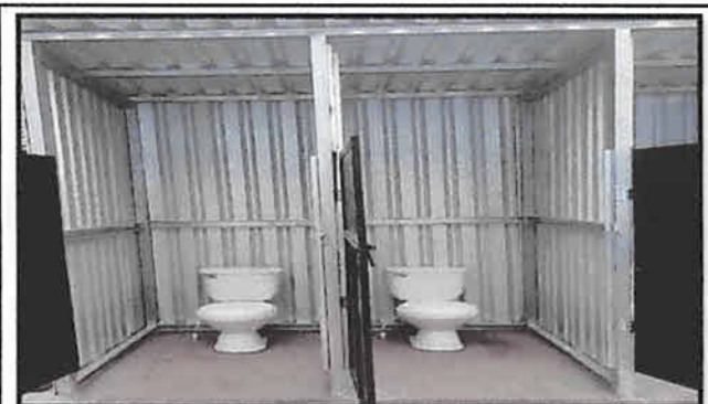
Foto 5: Reemplazo de sanitarios
