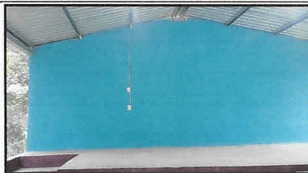
Foto 10 : Reemplazo de repello y cernido.
