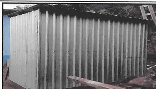
Foto 2: Mejoramientos de sanitarios con paredes de lámina trokelada y costaneras.
