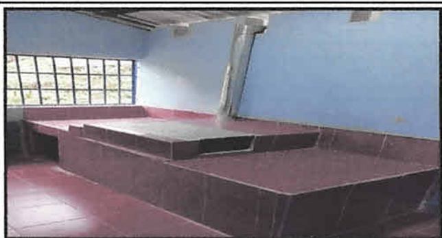
Foto 9: Reconstrucción de estufa con plancha y chimenea
