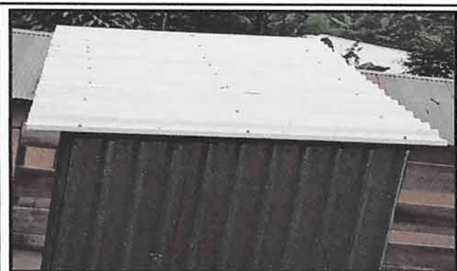
Foto 3: Reemplazo de techo y estructura metalica a los sanitarios.
