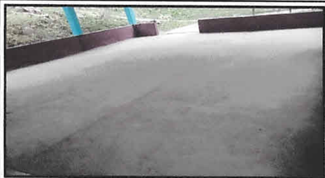
Foto1: Reemplazo de piso de salon y comedor
